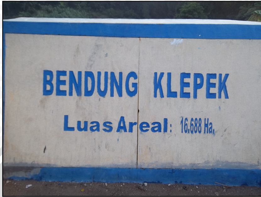
Gambar 3.2. Bendung Klepek Sumber : Dokumentasi Hasil Survei
