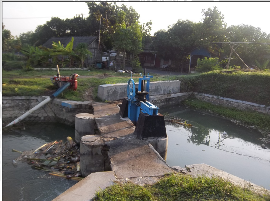
Gambar 3.7. Bangunan Bagi Sumber : Dokumentasi Hasil Survey
