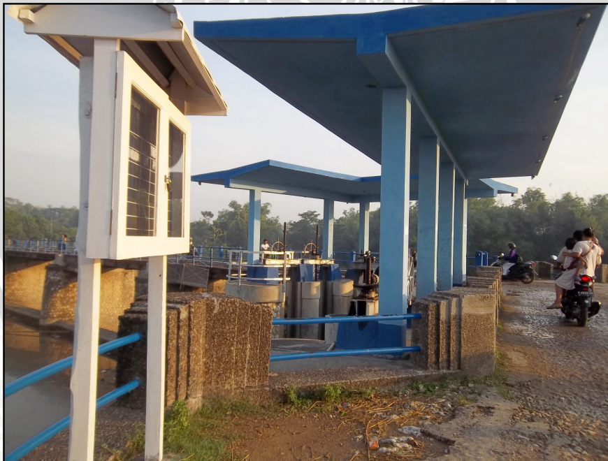
Gambar 3.3. Bendung Klepek Sumber : Dokumentasi Hasil Survei
