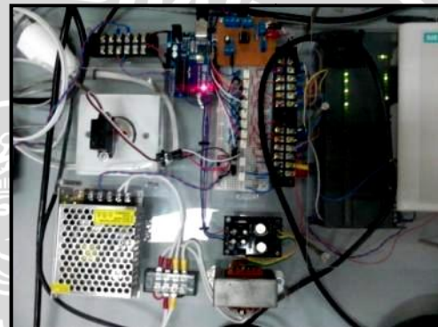
Rangkaian elektrik, dimmer , dan PLC
