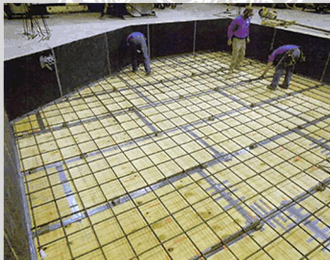
**Gambar 2. 20** Tahap akhir pemasangan material peredam
