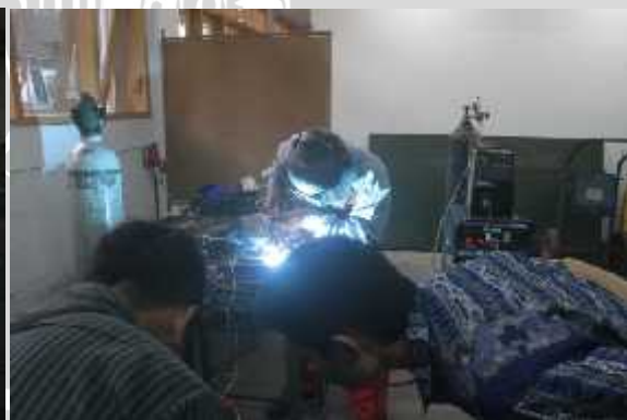
Pengamatan instalasi saat pengelasan
