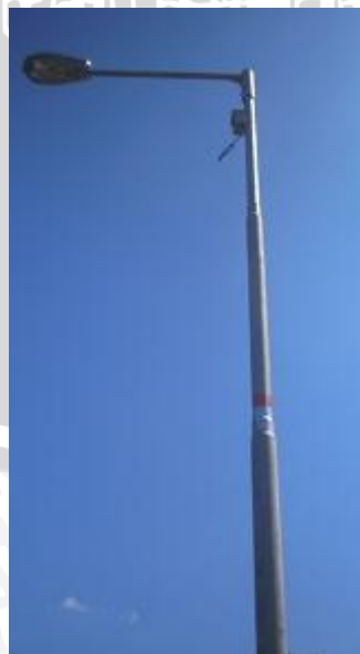
Gambar 2.23 Tiang Lampu PJU jenis Bulat ( Silinder ) Sumber : Hasil Survey PJU
