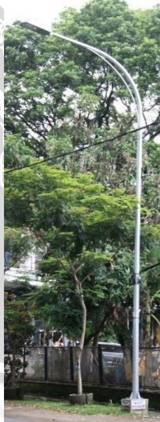
Gambar 2.21 Tiang Lampu PJU jenis Octagonal lampu SON-T Sumber : Hasil Survey PJU
