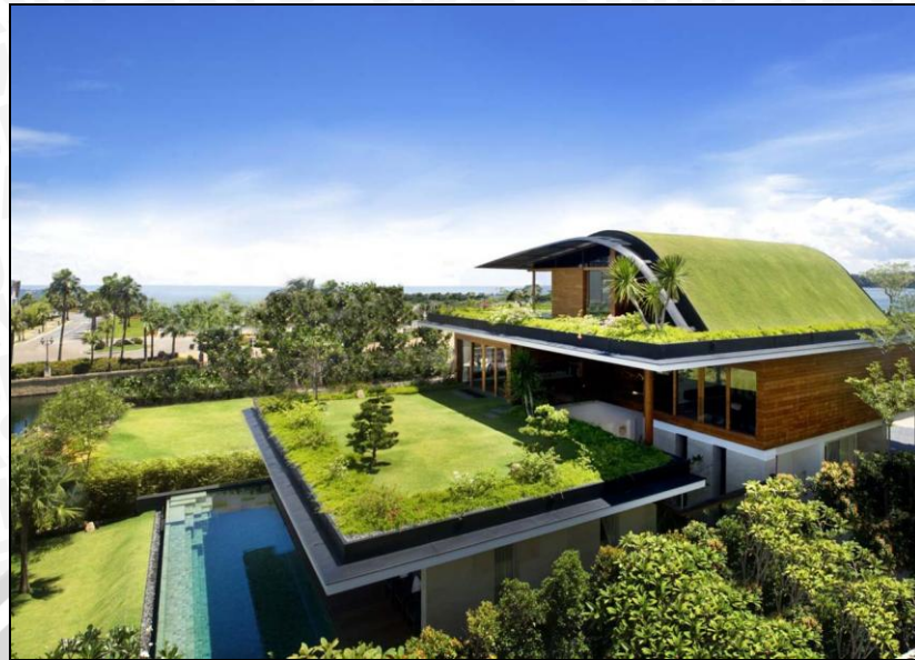
Gambar 4.27 Roof Garden (atap hijau)
