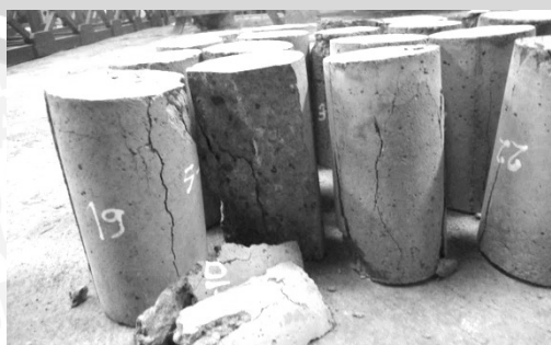
Gambar 4.1.2 Sisa benda uji tekan beton penyusun bata beton bertulang (Sumber: Hasil eksperimen)
