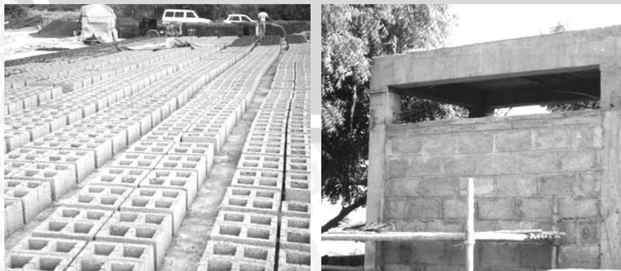
**Gambar 2.5.4** Konstruksi bata beton berongga penggunaan sebagai dinding anti gempa
