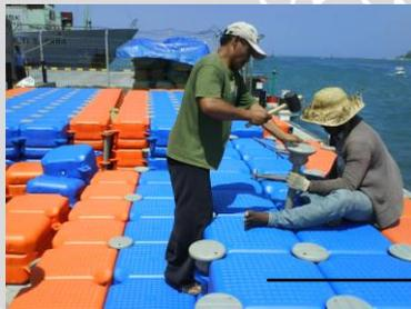
Jumlah eco float ada 4 susun. Masing-masing dengan ketinggian 35-40cm
