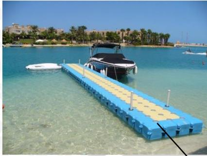
Seperti gambar di atas jumlah pontoon eco float yang di gunakan berjumlah 4 kotak mengikuti tinggi pontoon bangunan utama
