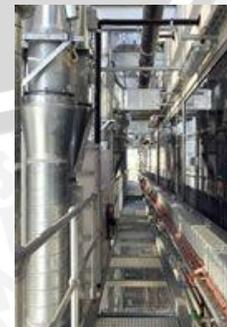
Gambar 2.3 Ruang peristitial memudahkan proses perbaikan peralatan MEE
