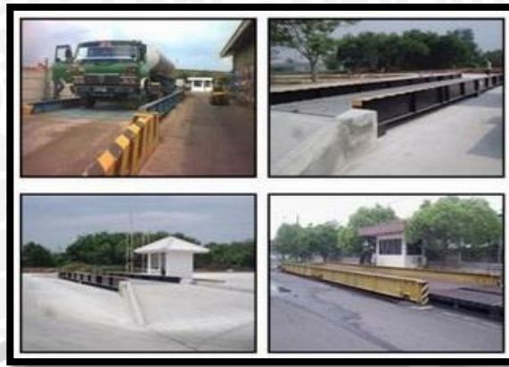
Gambar 2.1. Jembatan Timbang Konvensional
