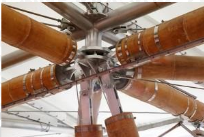
Gambar 2.47 : sambungan bambu modern pada atap tenda Sumber gambar : http://wiryanto.files.wordpress.com/2010/11/
