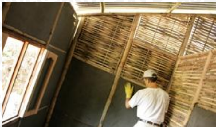
Gambar 2.19 : Bambu plester sebagai konstruksi dinding Sumber : habitatforhumanitykelowna.ca
