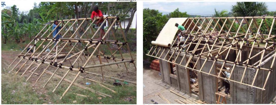
Gambar 2.9 : Struktur atap bambu
