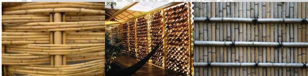
Gambar 2.20 : Bambu sebagai konstruksi dinding Sumber : http://arch.designcommunity.com/
