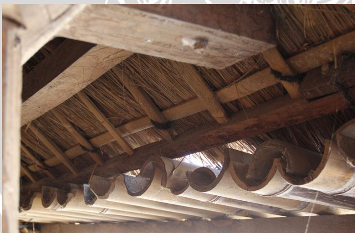
Gambar 2.15 : Konstruksi atap yang menggunakan bahan bambu Sumber : 02_Grass-roof-and-Bamboo-roof_Nagekeo_web
