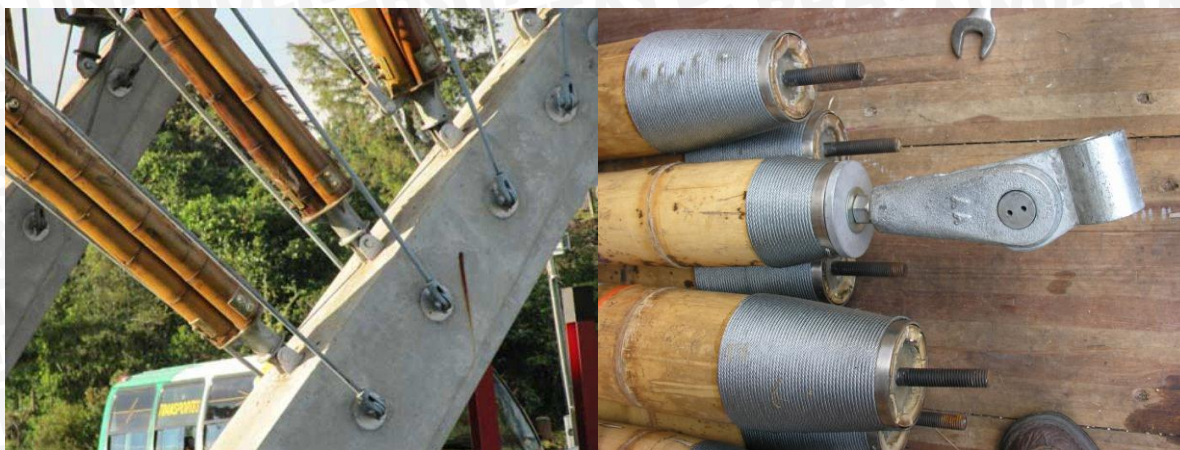
Gambar 2.55: sistem sambungan kerucut dengan penambahan kawat baja Sumber gambar : bamboe_24_constructie_www_expertfloorplan_net
