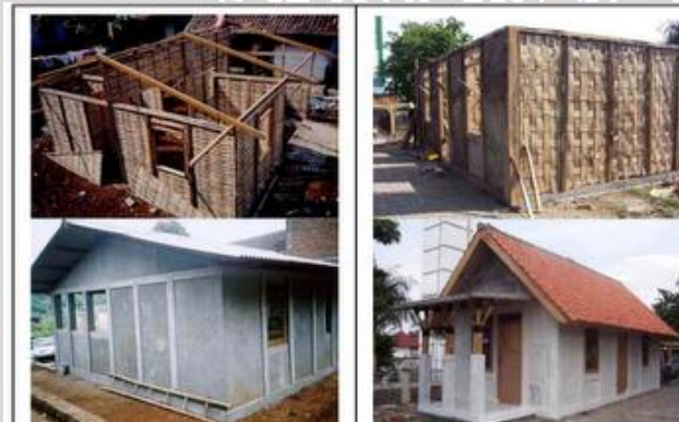
Gambar 2.10 : konstruksi bambu plester
