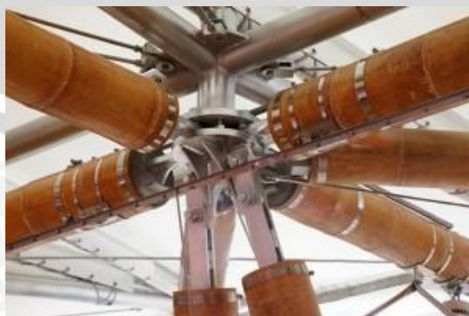
Gambar 2.18 : Sambungan Modern untuk kontruksi bambu pada atap tenda Sumber : http://wiryanto.files.wordpress.com/2010/11/
