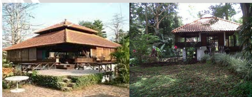
Gambar 2.59 : Bangunan PPLH dengan Material alami
