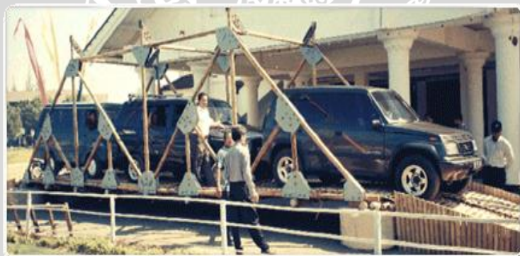
Gambar 2.56 : sambungan Morico untuk jembatan Sumber gambar : http://www.moriscobamboo.com/artikel_05.html
