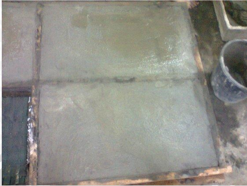
Gambar 5. Panel yang sudah dicor
