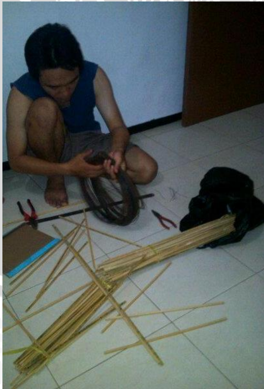
Gambar 2. Proses perakitan tulangan
