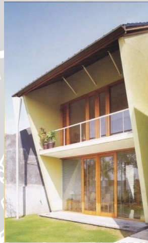
Gambar 2.7 : Bentuk balkon pada sebuah bangunan
