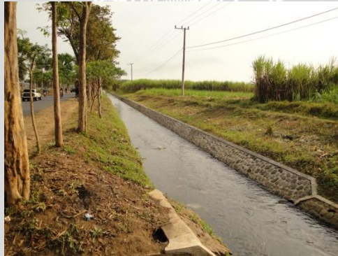
Gambar 4.2. Drainase terbuka serta area resapan Sumber: Dokumentasi Pribadi, 2011
