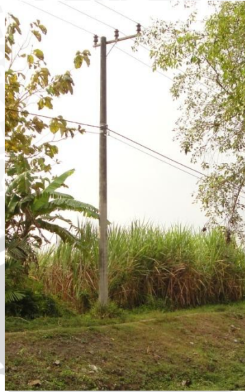
Gambar 4.3. Jaringan Listrik Sumber: Dokumentasi Pribadi,2011
