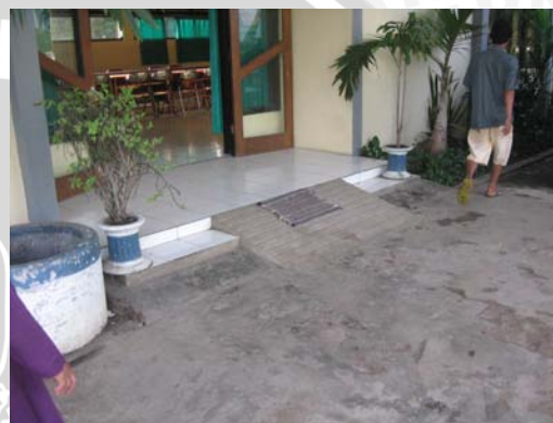
Gambar 2.21 Ram pada terasan masuk ke dalam bangunan
