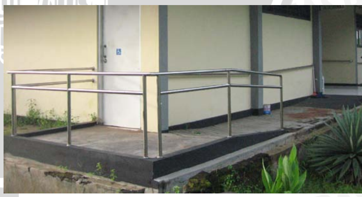
Gambar 2.23 Ram pada pintu keluar bangunan
