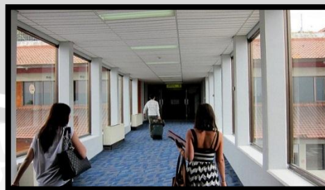
Gambar 4.42. Suasana koridor pada “overpass bridge” di terminal Bungurasih
