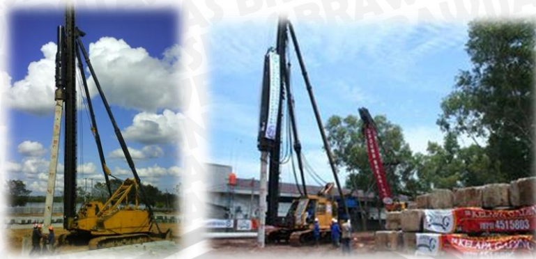
Gambar 4.53. Penerapan struktur tiang pancang pada bangunan
