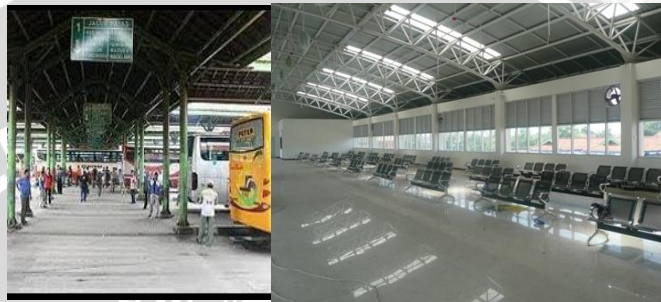
Gambar 4.52 Contoh penerapan struktur truss pada bangunan terminal
