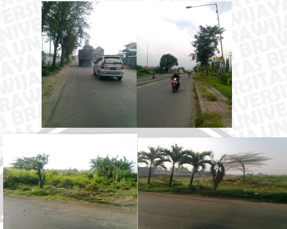
Gambar 4.25. Kondisi vegetasi dilapangan
