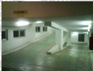
Gambar 4.41. Salah satu penerapan ramp didalam bangunan Rumah Sakit Dr Kariadi
