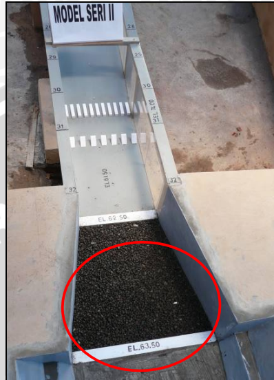
Gambar 4.31. Penambahan rip-rap pada terminal channel
