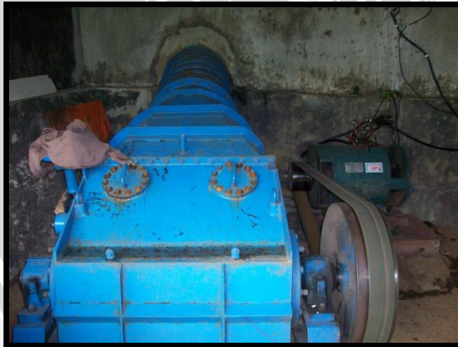
Kondisi di dalam PLTMH
