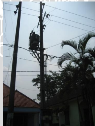
Gambar 4. 14 Gardu Listrik di Desa Sepanjang
