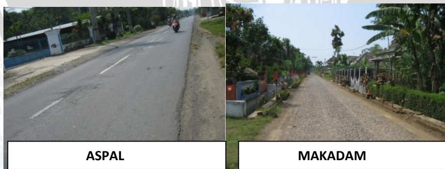
Gambar 4. 12 Perkerasan jalan di Desa Sepanjang
