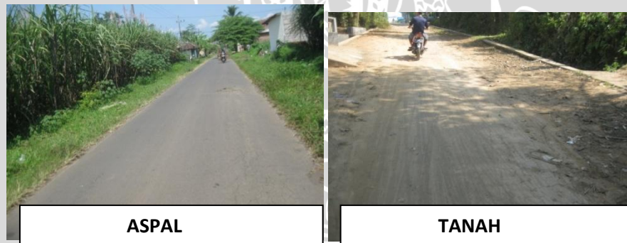
Gambar 4. 11 Perkerasan jalan di Desa Bulupitu
