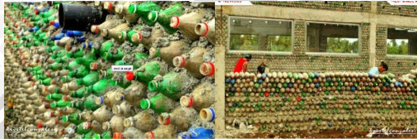
Gambar 2.25 Cara pemasangan botol plastik sebagai pengganti bata Sumber: http://inhabitat.com/asias-first-school-made-of-plastic-bottles-is-3x-stronger-than-concrete/
