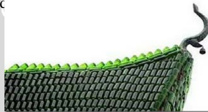
Gambar 2.28 Atap dan fasad bangunan yang disusun dari botol kaca bekas.
