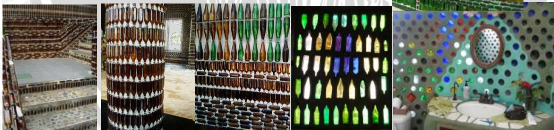
Gambar 2.29 Botol kaca sebagai penyusun railing tangga, lantai, kolom, dan bidang-bidang dinding.
