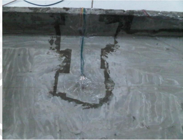
Pemasangan strain gauges pada perkerasan
