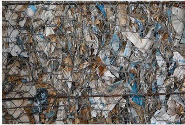
Gambar 2.14 Bal-bal sampah yang sudah disusun telah dilapisi dan diperkuat dengan kawat ayam. Setelah diperkuat seperti pada gambar, bal-bal sampah yang sudah disusun tersebut difinishing dengan semen seperti biasa atau yang disebut oleh Eichelberger dengan istilah mud stucco atau tanah liat
