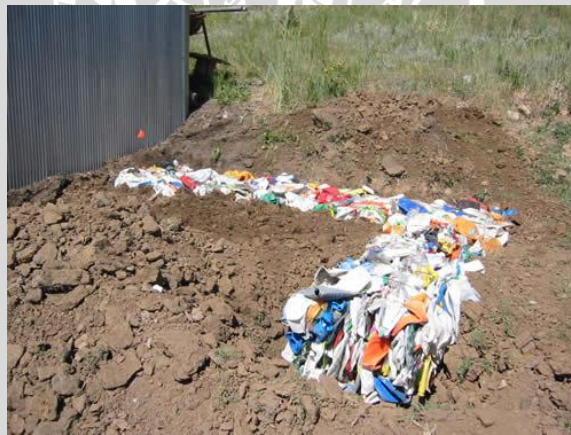
Gambar 2.11 Bal sampah kertas yang ditumpuk di atas pondasi bal sampah plastik Sumber: Eichelberger, 2007
