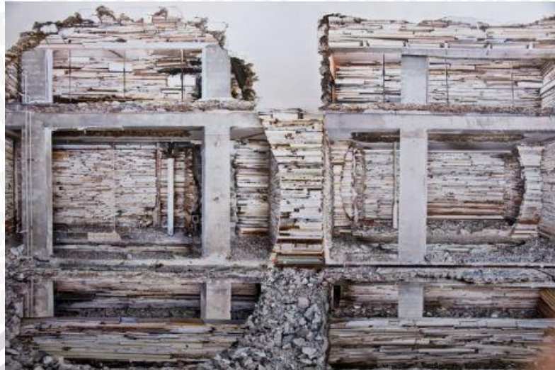
Gambar 2.4 Dinding yang sudah dilubangi sengaja tidak dirapikan kembali Sumber: Steph, 2011
