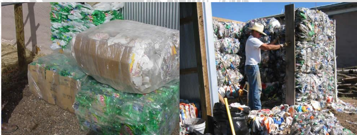
Gambar 2.13 Bal-bal sampah yang dikemas di lokasi pembangunan dan proses penyusunannya sebelum diperkuat dengan kawat jaring-jaring seperti pada konstruksi tanggul Sumber: Eichelberger, 2007
