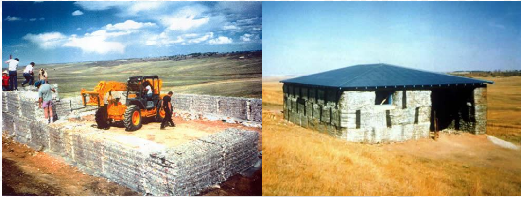
Gambar 2.12 Proses konstruksi dan rumah yang telah terbangun berdasarkan penelitian pertama Eichelberger pada tahun 1992 Sumber: Eichelberger, 2007
