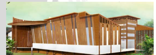
Dinding dengan bilah kayu galam, teraplikasi pada r. produksi
