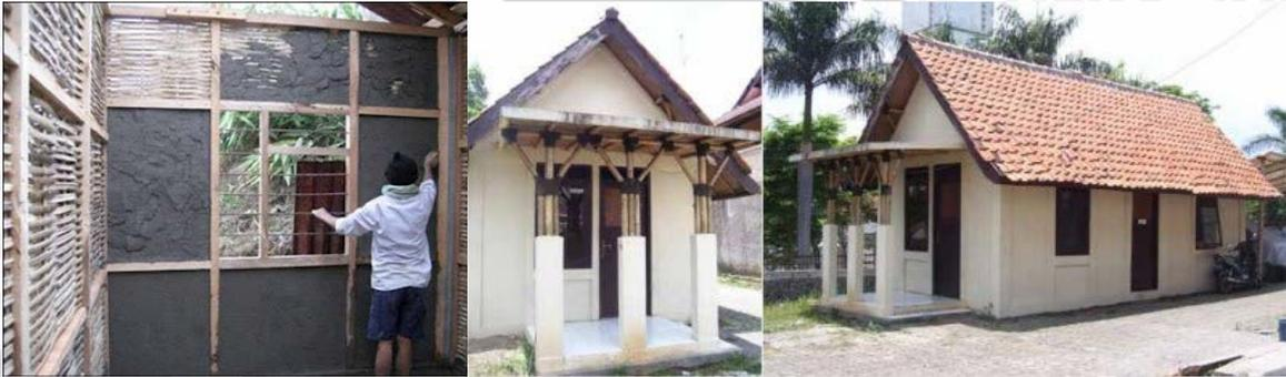
Gambar 2.8 penerapan bambu plester pada bangunan modern
