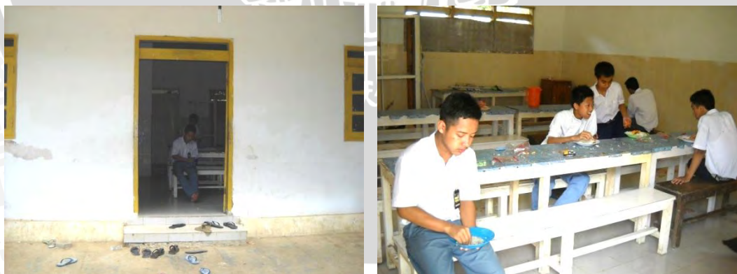
Gambar 4.59. Kondisi Eksisting Ruang Makan Santri yang ada di rumah tinggal Ustadz
