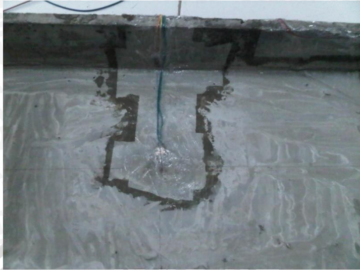
Pemasangan straingauge pada perkerasan
