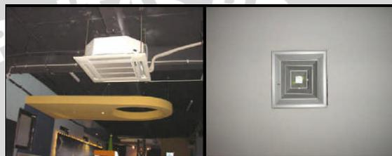
Gambar 2.76. Peletakkan AC Central
