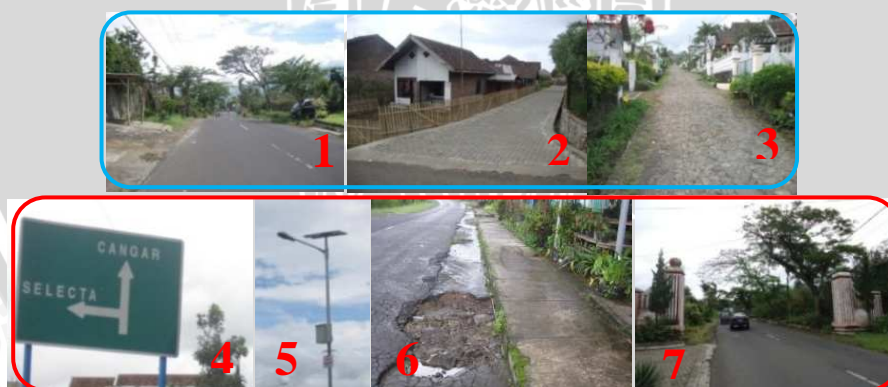
Gambar 4. 18 Kondisi Jaringan Jalan dan Fasilitas Pelengkap
