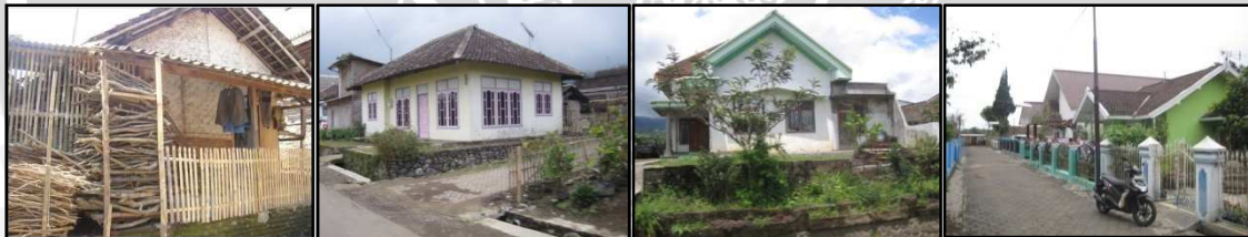
Gambar 4. 8 Kondisi Permukiman dan Bangunan Rumah Desa Tulungrejo
