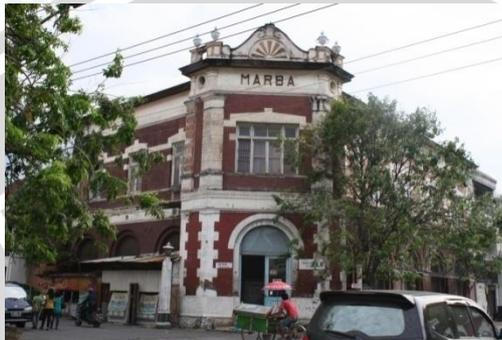
Gambar.4.105. Bentuk dinding dengan bata klinker pada kasus 2 di koridor Jalan Letnan Jenderal Soeprapto No.29
