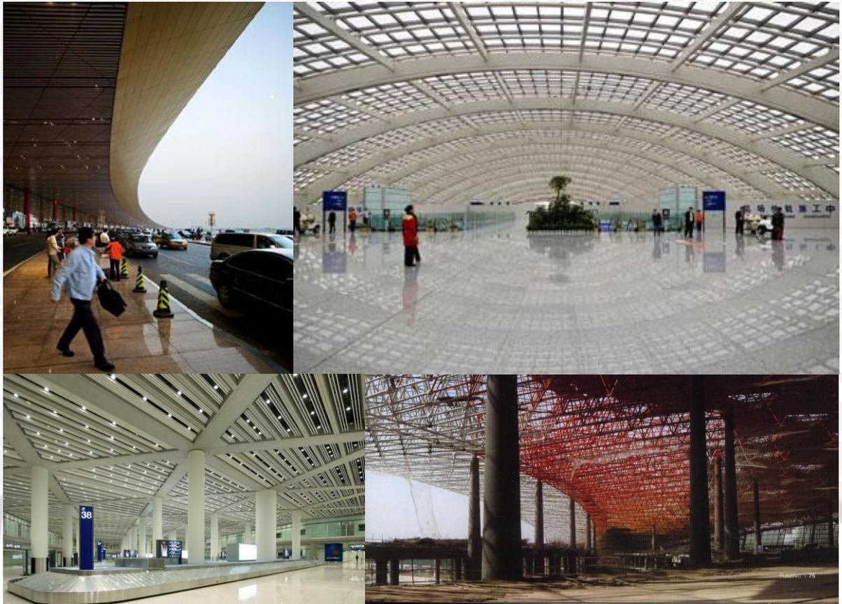
**Gambar 2.22** Struktur cantilever pada kerb dan *space frame* pada atap dengan struktur kolom beton sebagai penopangnya
