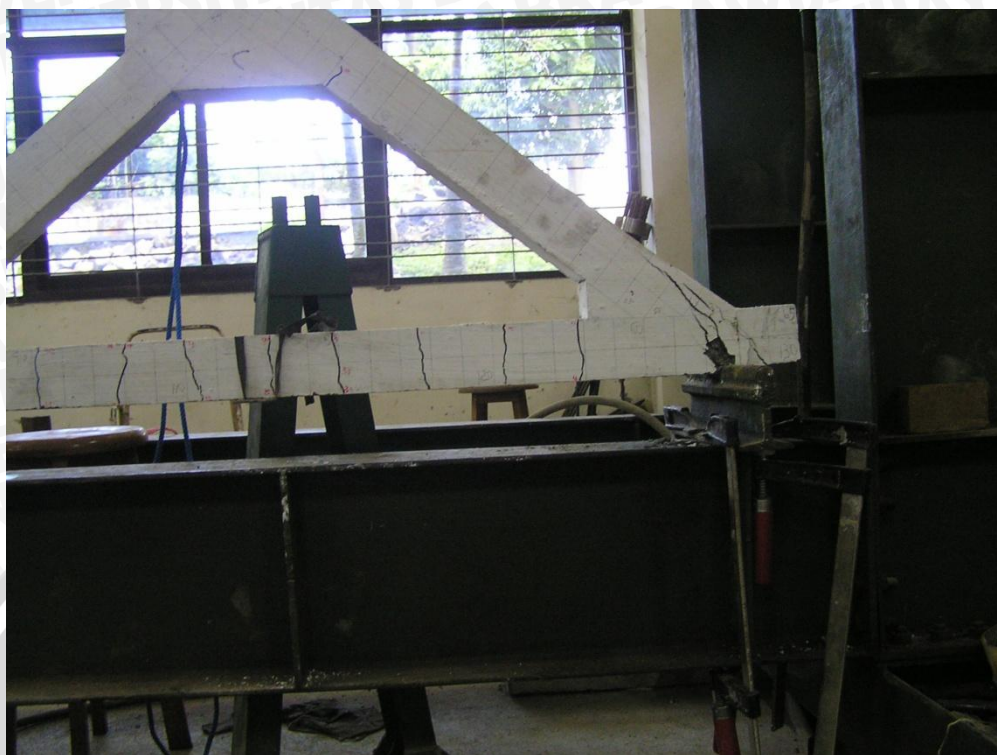
Retak yang terjadi pada batang tarik
