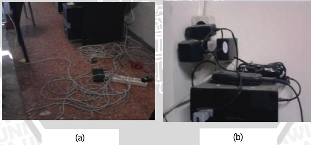
Gambar 4.1 Contoh Temuan Pemasangan Instalasi di Teknik Elektro Universitas Brawijaya yang Berpotensi Menyebabkan Kebakaran
