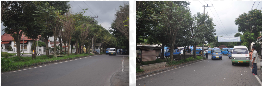
Gambar 4.13 Kondisi koridor Jalan Simpang Panji Suroso Sumber : Hasil pengamatan, 2010
