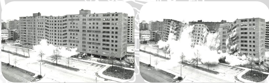
Gambar 1.1. Peledakan gedung Pruitt Igoe; titik tolak keruntuhan era modernism .
