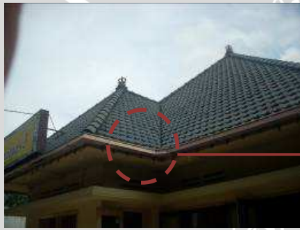
Gambar.4.18. Atap limasan dan penutup atap genteng keramik Sumber : Levana 2010
