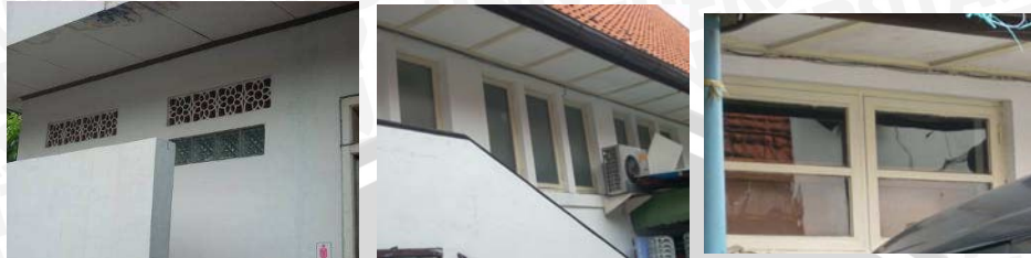
Gambar 4.110. Jenis ventilasi dan jendela pada Gereja Sumber : Levana 2010
