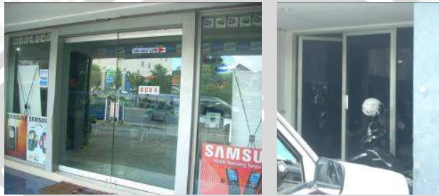
Gambar.4.65. Pintu masuk utama dengan material utama kaca Sumber : Levana 2010
