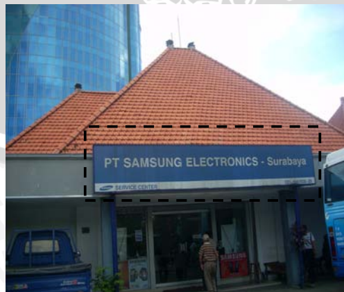
Gambar.4.62. Tampak depan bangunan Sumber : Levana 2010
