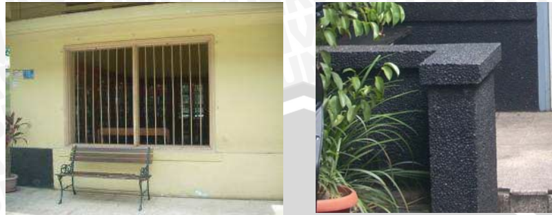
Gambar.4.20. Dinding dan aksesoris pada dinding bangunan Sumber : Levana 2010
