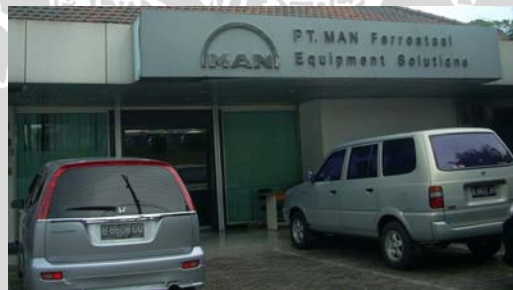
Gambar 4.188. Dinding pada depan bangunan Sumber : Levana 2010
