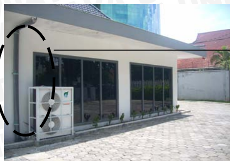
Gambar 4.40. Peletakan talang pada bangunan Sumber : Levana 2010
