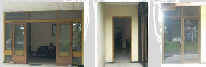
Gambar. 4.102. Jendela kaca dan pintu utama dan pintu samping Sumber : Levana 2010
