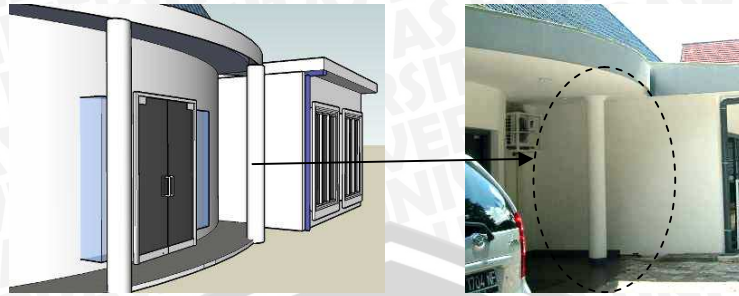
Gambar.4.45. Kolom pada fasad teras Sumber : Levana 2010
