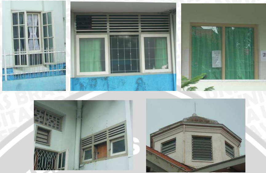
Gambar 4.142. Macam Jendela dan ventilasi pada rumah sakit Sumber : Levana 2010
