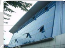
Gambar .4.179. Dinding alkubonce dan dinding kaca Sumber : Levana 2010
