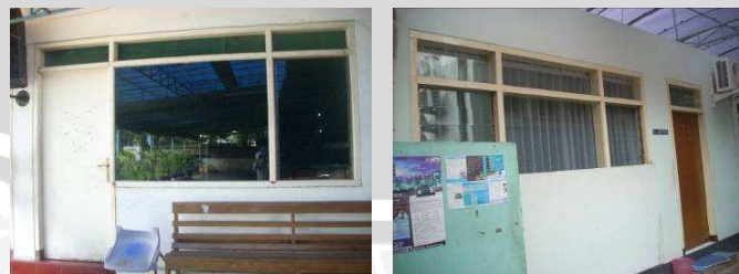
Gambar 4.112. Pintu dan jendela pada gereja pada kantor pengelola Sumber : Levana 2010
