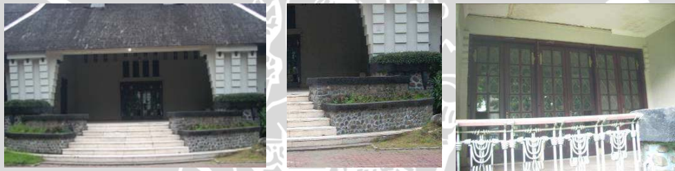
Gambar 4.118. Dinding bata pada selubung bangunan(kiri), batu alam pada dinding samping (kanan) Sumber : Levana 2010
