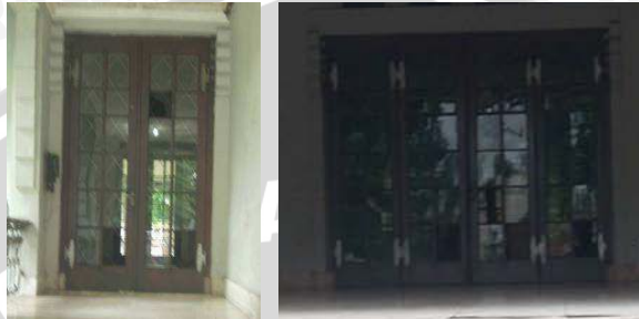
Gambar 4.120. Pintu dan jendela pada museum Sumber : Levana 2010
