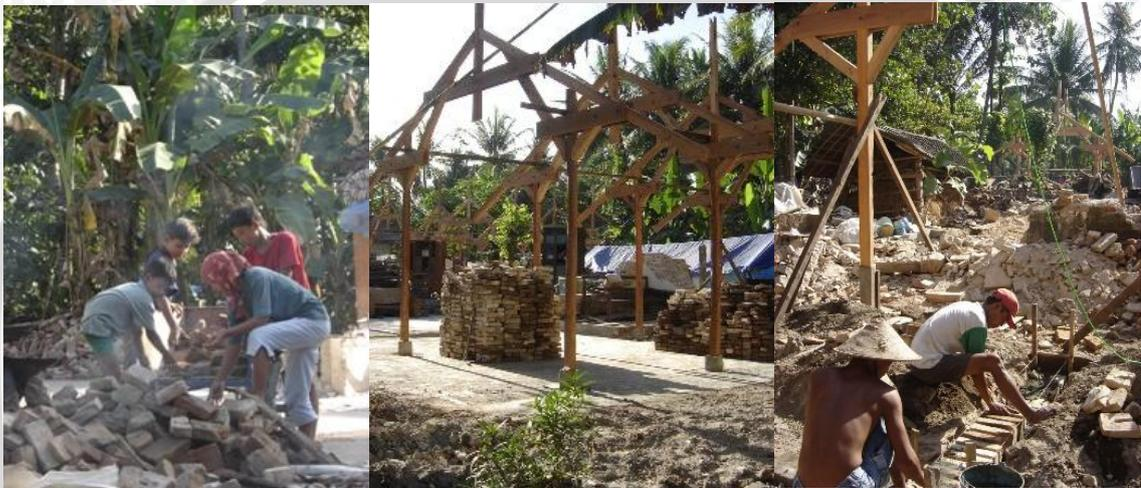
Gambar 4.13 Material batu bata dari reruntuhan bangunan dikumpulkan untuk digunakan kembali
