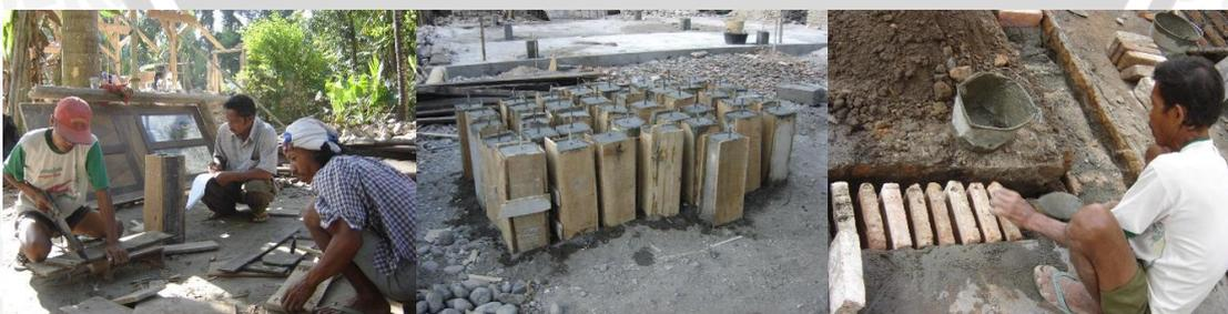
Gambar 4.9 Pekerjaan pembuatan umpak dan pemasangan pondasi
