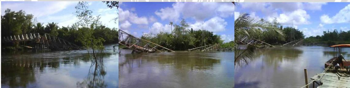
**Gambar 4.41. Jembatan Neto yang Mengalami Kerusakan**
