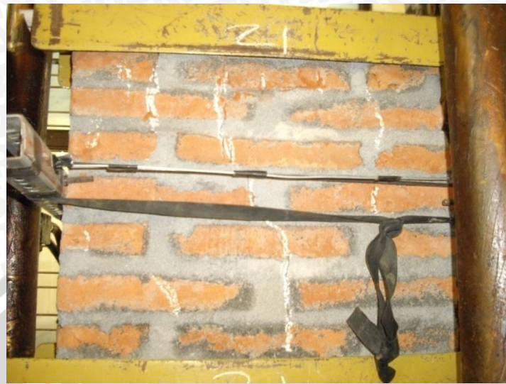
Gambar 17. Pola retakan yang terjadi pada dinding bata komposisi mortar 1:5, benda uji 3
