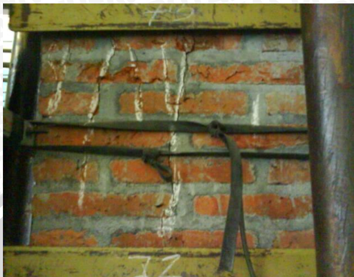
Gambar 19. Pola retakan yang terjadi pada dinding bata komposisi mortar 1:7, benda uji 2
