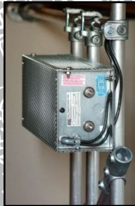
Gambar 2.11 Resistor pengereman dinamik pada turbin angin Sumber: solar navigator, 2005
