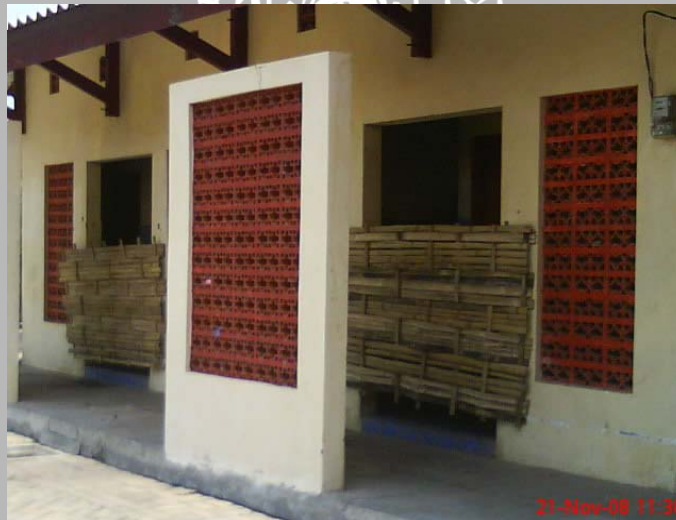
Gambar 4.3.1.4 Kamar mandi / toilet
