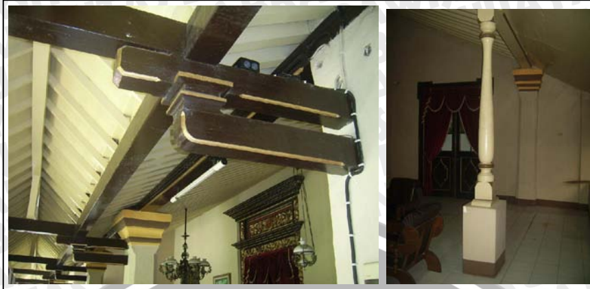
Gambar 4.23. Detail sosoran atap dan kolom serambi dalem Keraton (Sumber : Dokumentasi Pribadi 2009)
