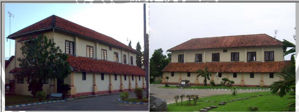
Gambar 4.8. Gedung Loteng Keraton (Sumber : Dokumentasi Pribadi 2009)
