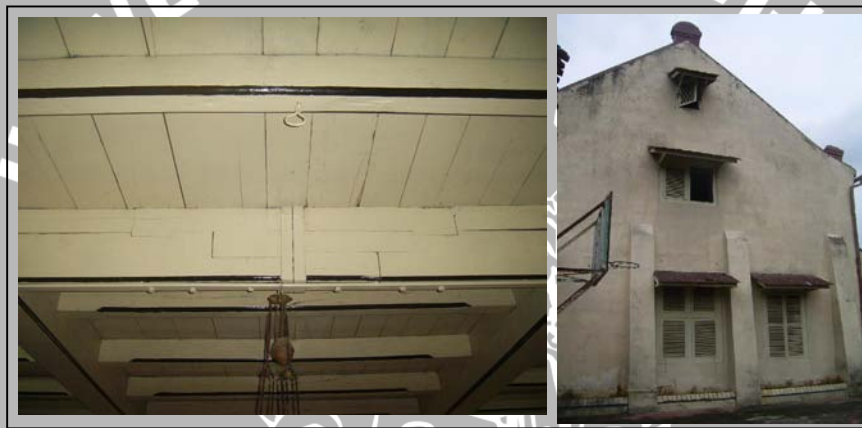
Gambar 4.22. Detail sambungan balok lantai 2 dan Bearing Wall Dalem Keraton (Sumber : Dokumentasi Pribadi 2009)
