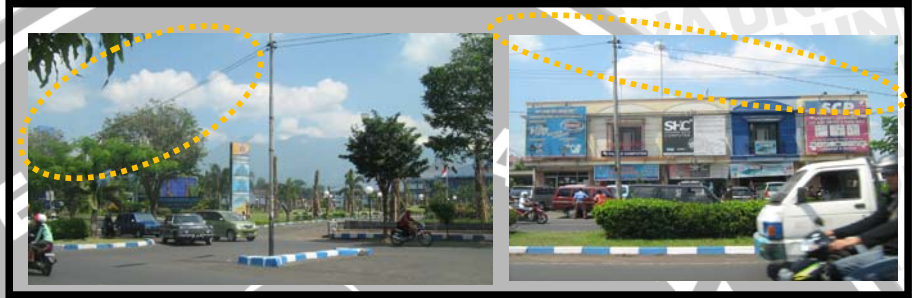
Gambar 4.43 Kondisi eksisting saluran listrik udara
