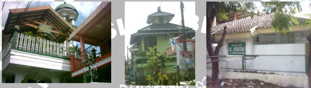
Gambar 4.181 Fasilitas Tempat Ibadah di Lokasi Studi
