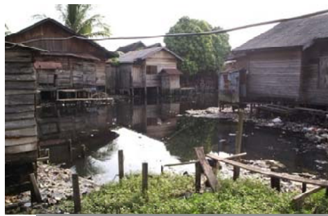
Gambar Foto 5.12 Sampah Yang Terbawa Aliran Sungai Menumpuk Dan Tersangkut Pada Tiang Bangunan Rumah Warga Yang Berada Di Atas Badan Sungai
