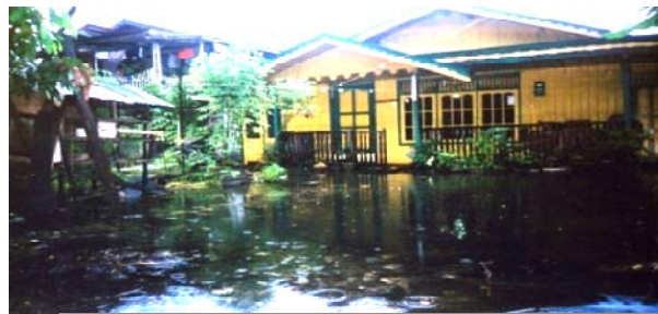
Gambar Foto 5.1 Genangan Air Hujan Yang Tidak Dapat Dialirkan Karena Tidak Ada Saluran Drainase, Tahun 2007
