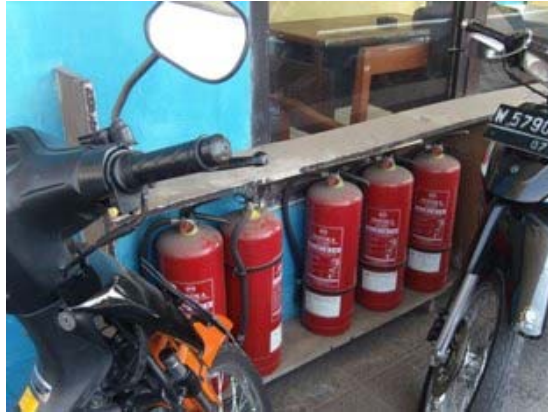
Gambar 4.13 Alat Pemadam Kebakaran
