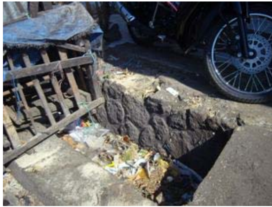
Gambar 4.8 Saluran Drainase Terbuka di Pasar Batu
