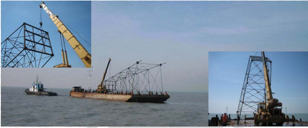
Gambar 2.8 Persiapan soil investigation (Dokumentasi Dept. Pekerjaan Umum dan Pemprov Jatim).
