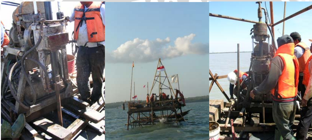
Gambar 2.9 Pelaksanaan SPT di lokasi proyek (Dokumentasi Dept. Pekerjaan Umum dan Pemprov Jatim).
