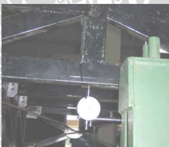
Gambar pemasangan dialgauge
