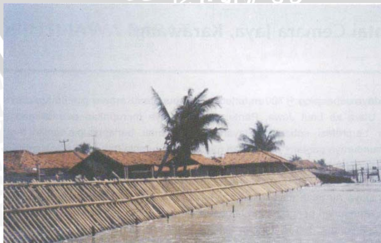
Gambar Struktur Revetment dari Cerucuk Bambu
