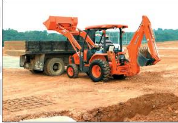
Gambar 4.17 , Dump Truck dikombinasikan dengan Wheel Loader
